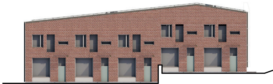
Julkisivu itään, B-talo
