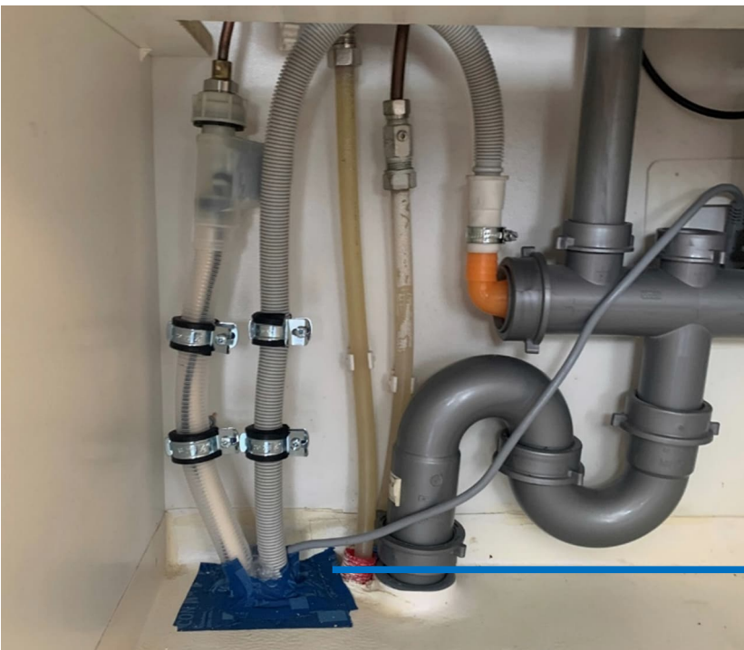
Esimerkki ohuella muovimatolla ja tiivistystelpillä tehdystä tiivistyksestä.
